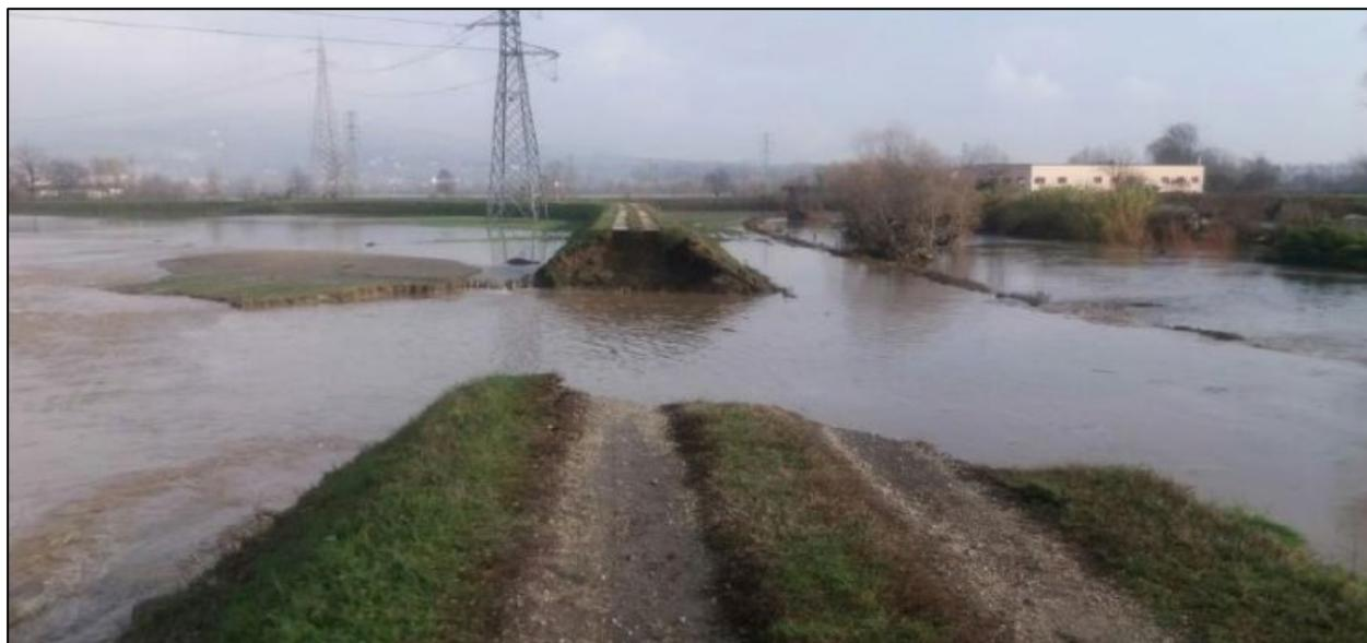
*Figura 11 – (sopra) vista da monte verso valle dell'argine sinistro del T.Chisola. Raggiungimento della sommità e inizio della tracimazione (25/11/16 h 11:00). Fonte AiPo; (sotto) rotta arginale a valle del ponte di strada Barauda. Vista da valle verso monte. Fonte AiPo.*
